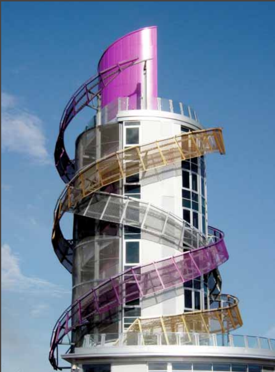
FACCIATA DECORATIVA PARCHEGGIO - REDCAR - INGHILTERRA DECORATIVE FACADE - REDCAR - ENGLAND
