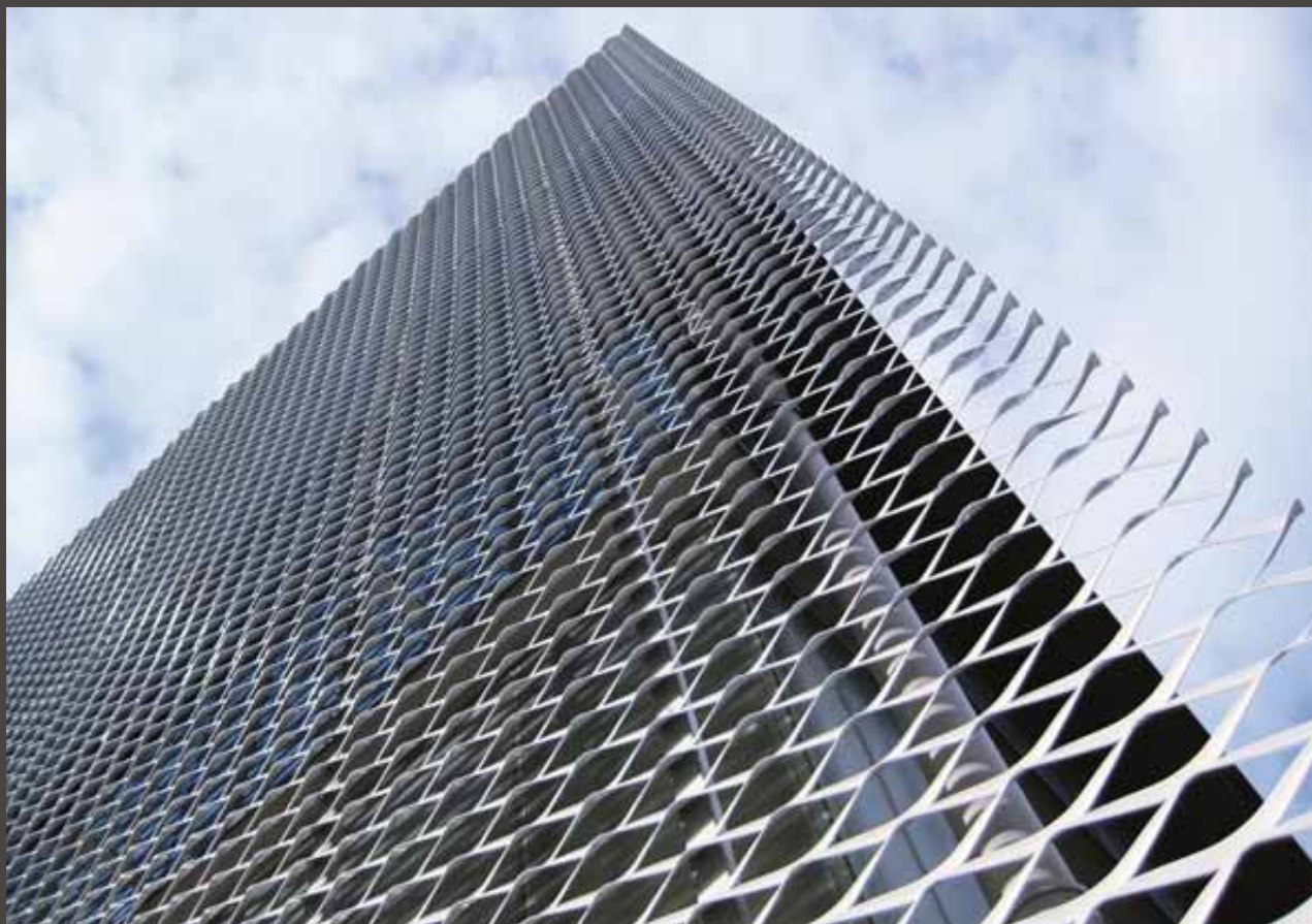
FACCIATA IN LAMIERA STIRATA VERNICIATA. PROGETTO DI RIQUALIFICAZIONE DI UN CAPANNONE INDUSTRIALE - GERMANIA FACADE IN LACQUERED EXPANDED METAL. PROJECT FOR RETRUCTURING OF AN INDUSTRIAL BUILDING - GERMANY
