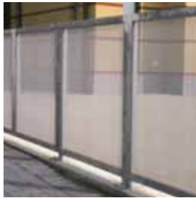
PARAPETTI PARCHEGGIO - TORINO - ITALIA PARK RAILING - TURIN - ITALY
