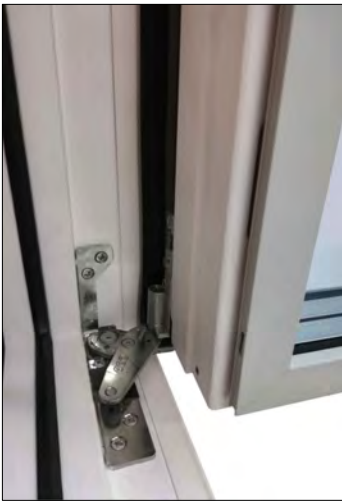
Cerniere a scomparsa per apertura anta a 105°
